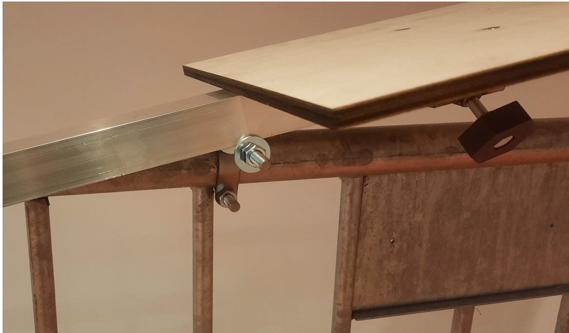
Figuur 7: Foto van de oplegging
