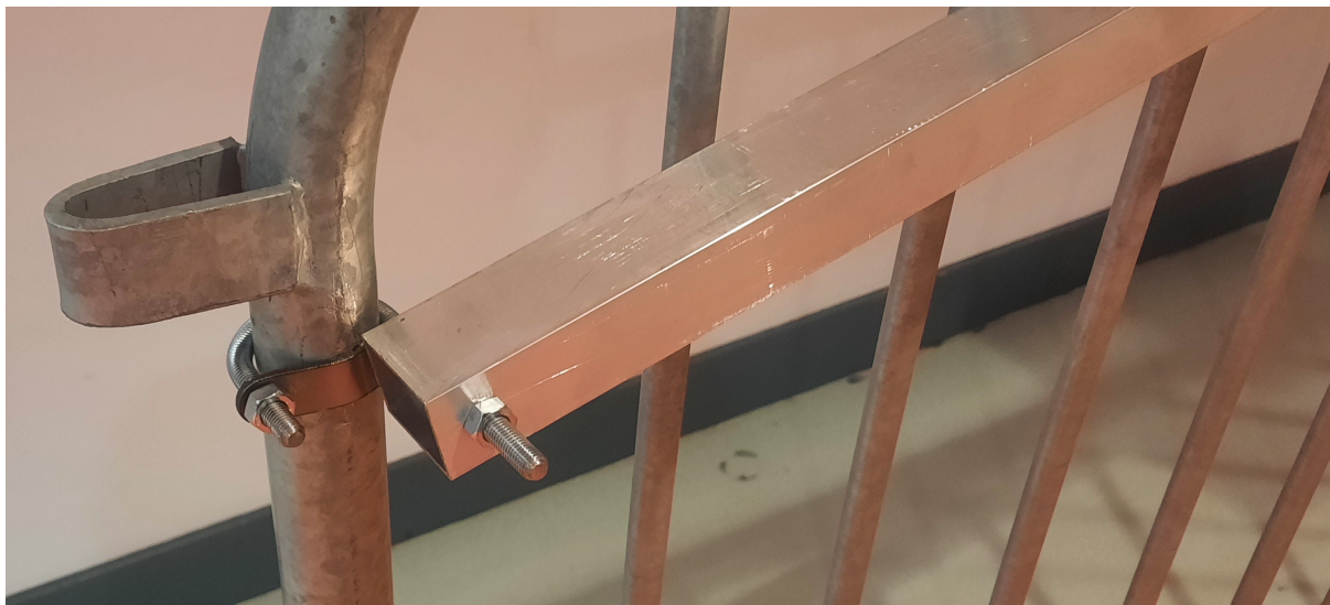
Figuur 6: Foto van het scharnier
